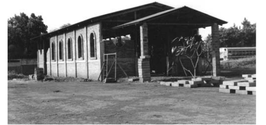
완공 직전의 마사야 장로교회 전경
