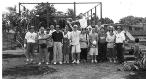
니카라과 마사야 제일교회 성전 건축 벽돌 쌓기 사역
